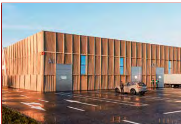
Меблева фабрика та магазин Віяр, Одеса, вентиляційні установки АНЕ-300WB1 (4 шт.)
